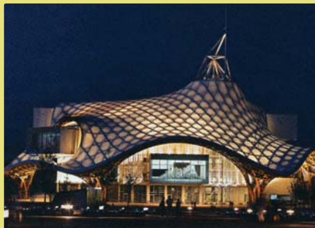
Dach des Centre Pompidou als Holzkonstruktion.
